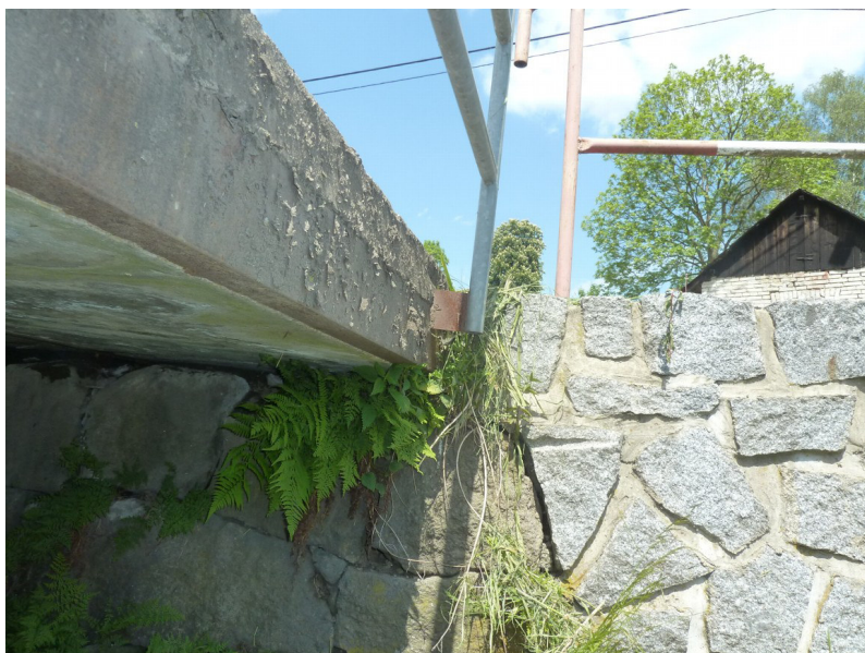
Detail pravé opěry a boku NK na vtoku, uchycení sloupků zábradlí
